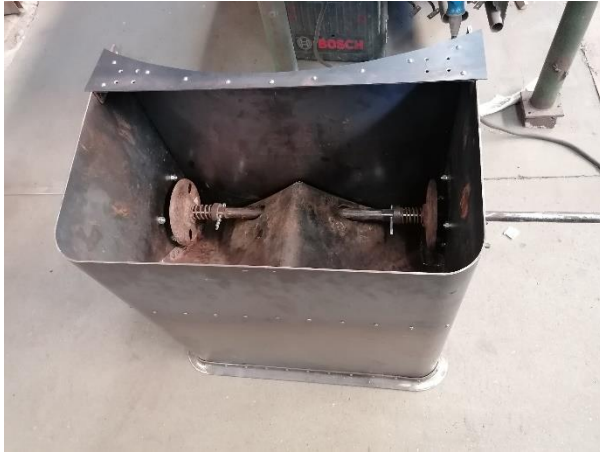
Sablère entièrement rivetée comme à l'origine
