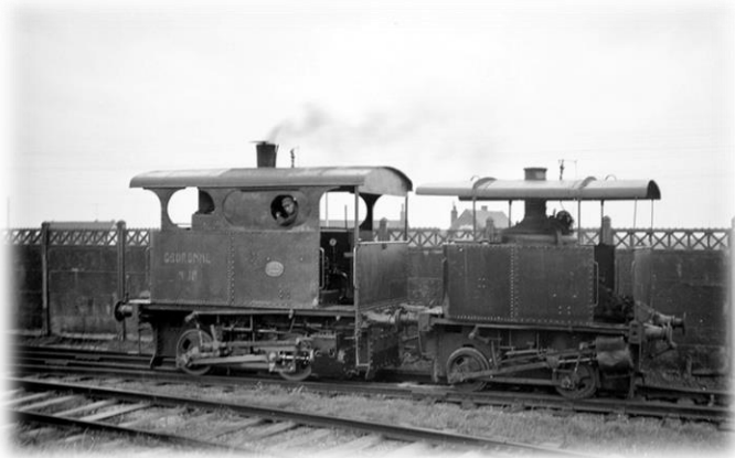
La Couronne n°18 à gauche avec la Type III dans la cimenterie de Dannes
