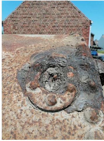
Autoclave de chaudière
