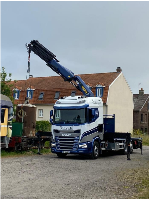
Démontage de la chaudière en juin 2023
