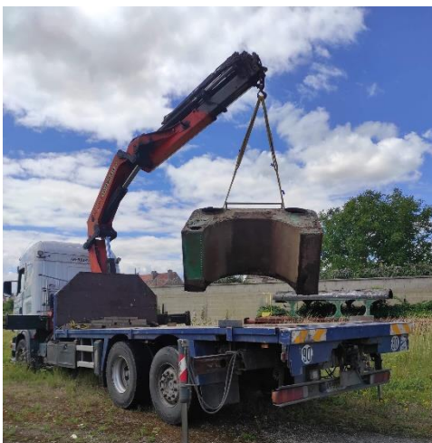
Levage de la bache à eau
